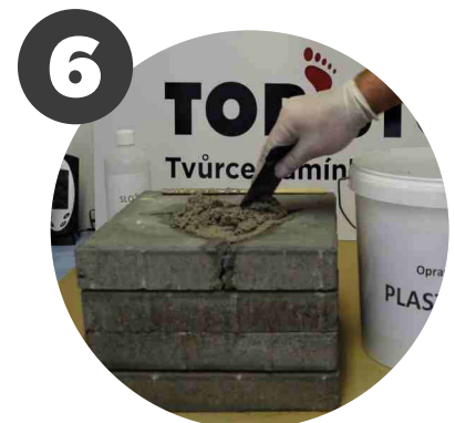
Připravenou směs nanášíme a důkladně uhladíme přiloženou stěrkou či ocelovým hladítkem (pracujeme rychle, směs se musí zpracovat do 30minut od namíchaní)
