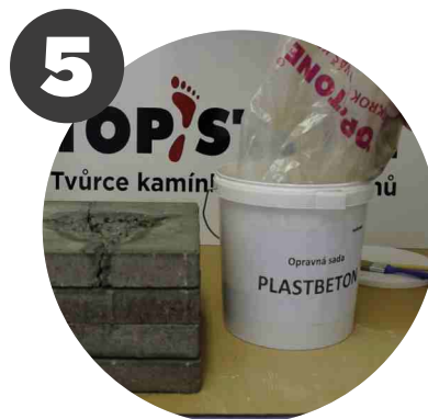
Speciální plnivo sl.C vsypeme do kbelíku s již namíchanou hmotou a důkladně promícháme buď přiloženým dřevěným míchadlem nebo elektrickým míchadlem
