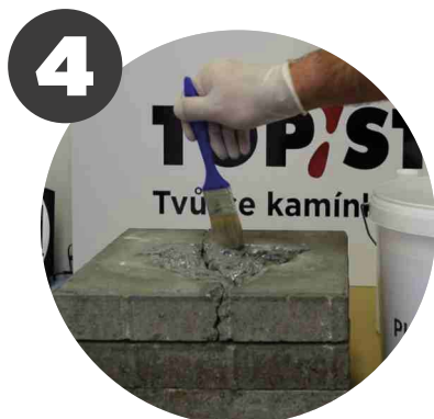
Příloženým štětcem natřeme smíchanou hmotu na opravovaná místa
