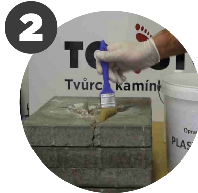
Příloženým brusným papírem očistíme opravovaný povrch, následně přiloženým štětcem očistíme povrch od prachu
